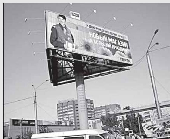
**СУПЕРБОРДЫ И СУПЕРСАЙТЫ** – щитовые рекламные конструкции большого формата, имеющие внешние поверхности, специально предназначенные для размещения рекламы. Суперборды и supersайты состоят из фундамента, каркаса, опоры и информационного поля. Суперборды и supersайты должны иметь внутренний или внешний подсвет. Количество сторон у супербордов и supersайтов не может быть более трёх.
