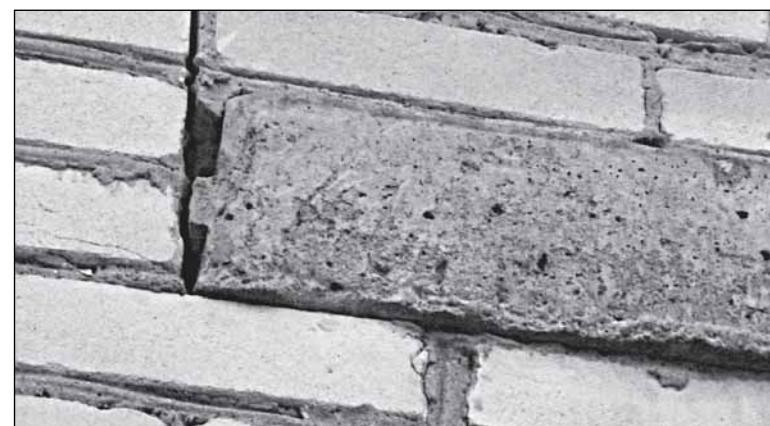
В стенах - трещины, кирпичи вываливаются
