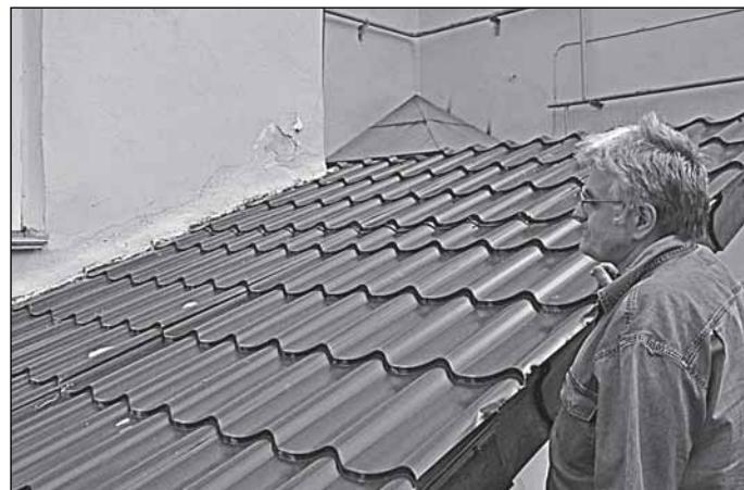
(тепло поднимается вверх), она является пароизоляцией для металла, который положили сверху. По сути, строители испортили весь материал, разрезав металлическую крышу болгаркой. На сегодняшний момент от этой крыши отрываются листы, на старом покрытии собирается конденсат и капает на теплоизолатор, который просто накрыт целиком. Вместо 150 мм слоя утеплителя эксперты увидели 5-10 см.
