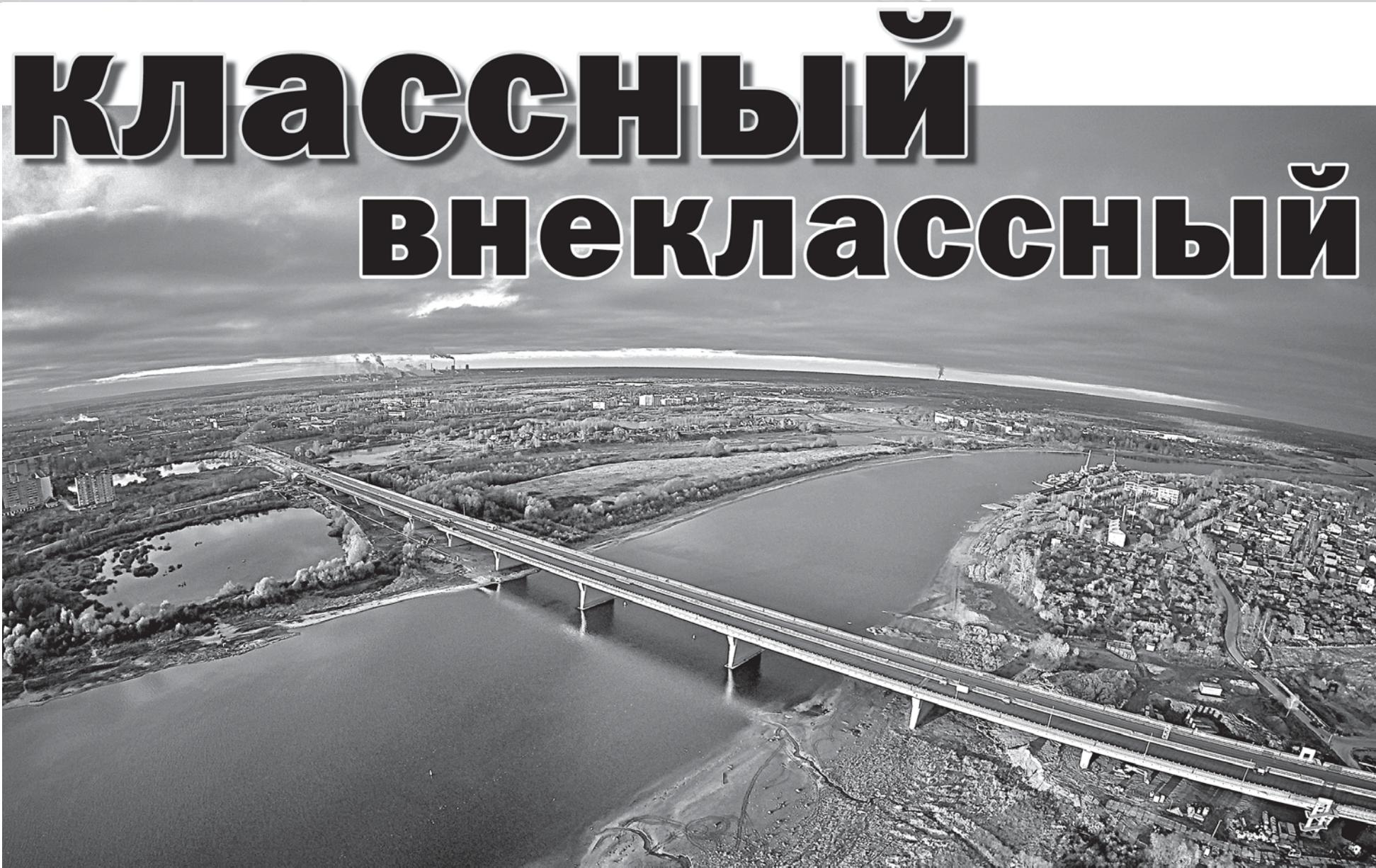
Шесть оранжево-красных и жёлтых тяжело груженых щебнем, бетоном и песком машин (по товарно-транспортным накладным весом по 40 и более тонн каждая) медленной вереницей въезжают на мост и располагаются близко друг от друга, по три в ряд, на середине очередного пролёта между опорами. Сегодня – завершающий день испытаний моста на прочность. Сегодня можно будет сказать, что мост родился.
