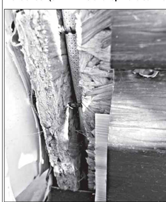
Угловое крепление OSB-панелей без брусков, щели, дыры обшивки, отсутствие влагозащитных пленок.
