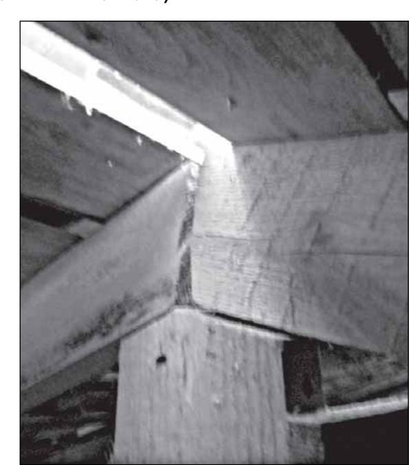
Разъезжающиеся стропила, отсутствие должного крепления деревянных элементов крыши. Пластин крепления нет.
