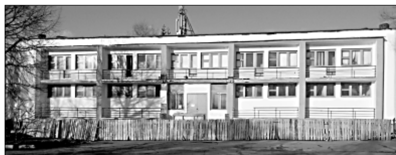
Гребная база: реконструкция не завершена
